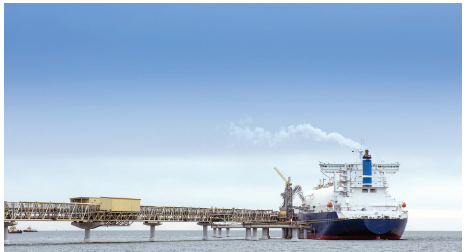
A docked LNG tank ship is about to unload LNG to an onshore LNG tank storage terminal.
